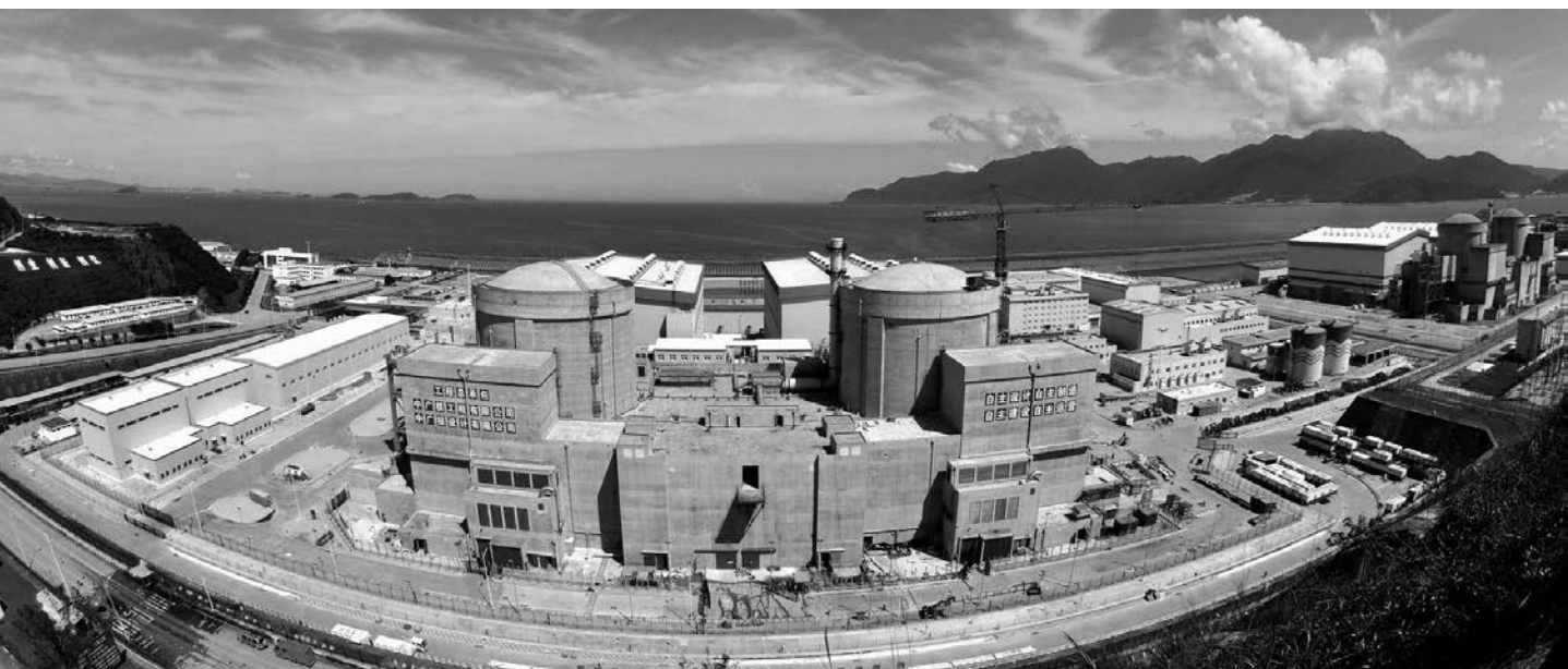
Figure 7. Les deux tranches PWR de 1 000 MW de Ling Ao II, à côté de Daya Bay, réalisées entre 2005 et 2011, tête de série de la filière chinoise de 2 e génération + CPR-1000 (photo : CGN)
