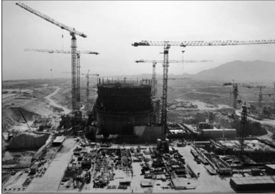
Figure 8. Début de la construction des deux tranches EPR de Taishan, au sud de Macao, avec un partenariat franco-chinois (CGN-EDF-Areva), qui seront achevées fin 2015-courant 2016 (photo : CGN)
