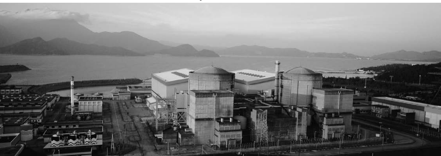
Figure 3. Daya Bay, construite entre 1983 et 1994, au nord de Hong Kong : la deuxième centrale nucléaire chinoise avec ses deux tranches à eau pressurisée inspirées de Gravelines (France)
