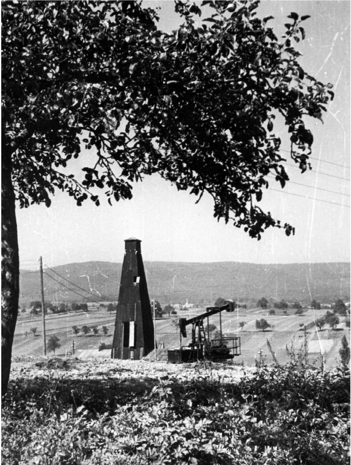
« Heidenboesch Tour Nordhausen n° 23 et pompage n° 4576 » : vue du champ d'exploitation avec une tour de forage de type Nordhausen (n° 23 de la concession) et une pompe à balancier sur le puits n° 4576 / Coll. Musée Français du Pétrole - Pechelbronn
