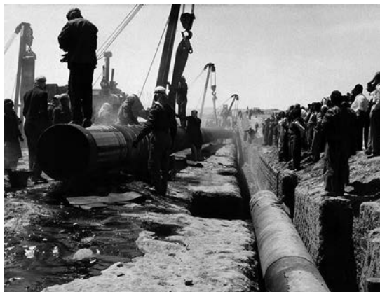
Figure 1. Pose du pipeline de 30 pouces entre Kirkuk et Banias (Irak-Syrie) en 1952 (Archives Total)
