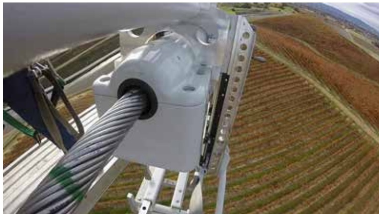
Figure 19. Expérimentation en Haute-Garonne d'un capteur dynamic line-rating Intesens
