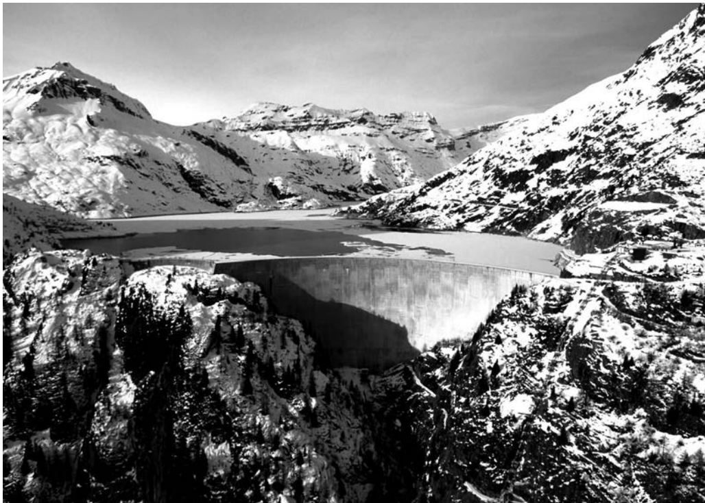
Barrage d'Emosson. Barrage géré dans le cadre d'une répartition franco-suisse des eaux utilisées (50-50). Partenariat historique 50% Alpiq, 50% EDF. Aujourd'hui, Alpiq dispose de la totalité de l'énergie et de la puissance.
