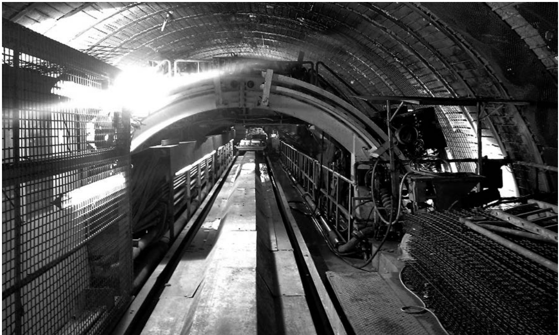
Chantier de construction de la STEP de Nant de Drance.
