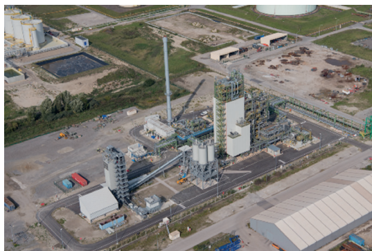
Unité de démonstration de Dunkerque
