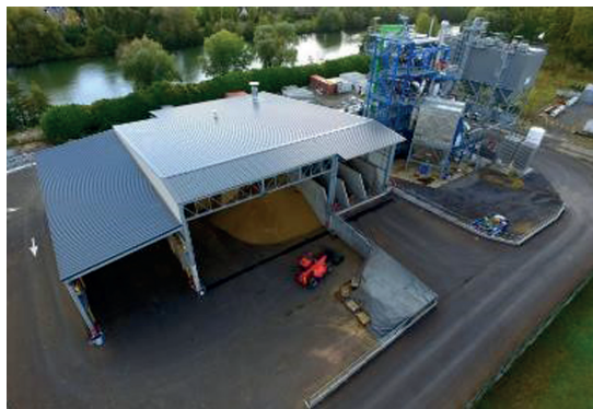
Unité de démonstration de Venette
